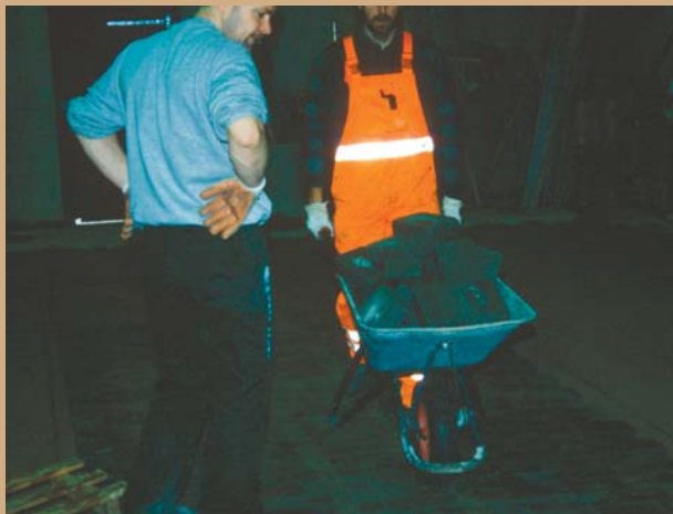
Transport af belægningssten med trillebør.
