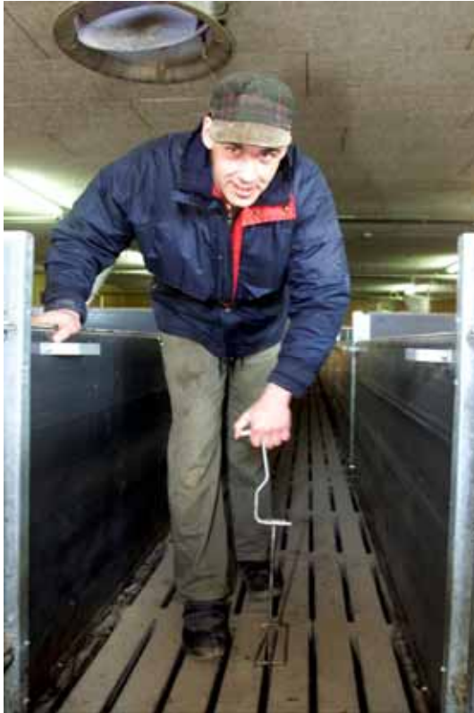
Udslusning af gylle indebærer risiko for alvorlige ulykker med svovlbrinte Foto: Dansk Svineproduktion
