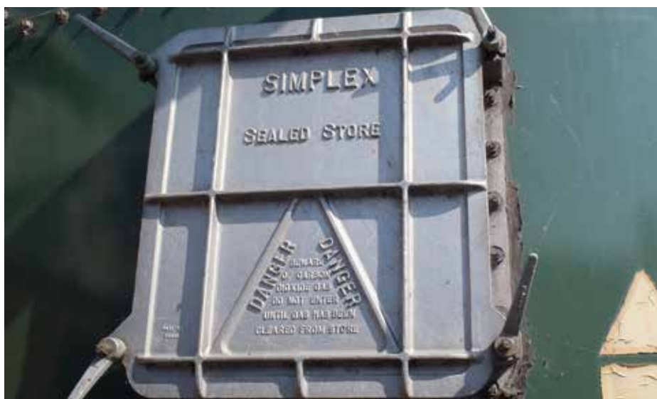
Mandeluge på gastæt silo med advarsel om CO 2 -gas og påbud om at tilføre ilt før man går ind.
