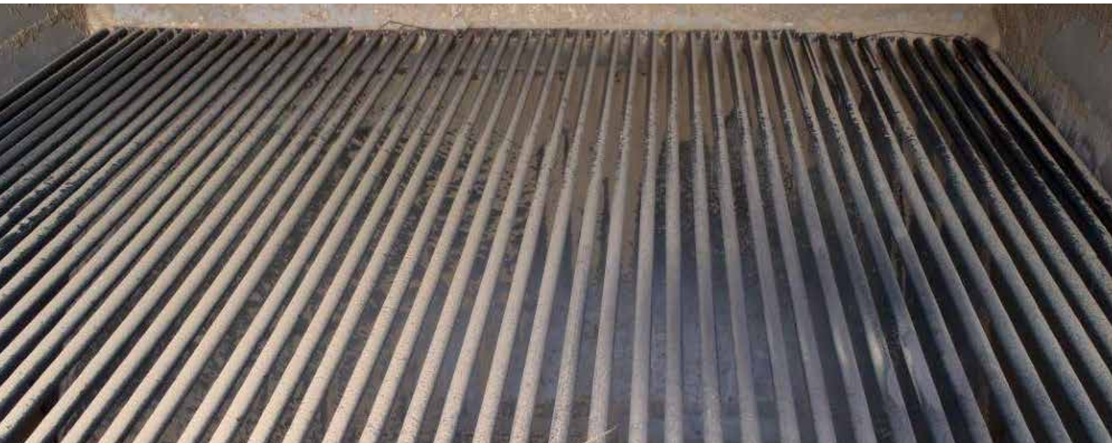
Overdækning på korngrav – tre-fire cm mellem rør, så man ikke kan få en fod igennem.
