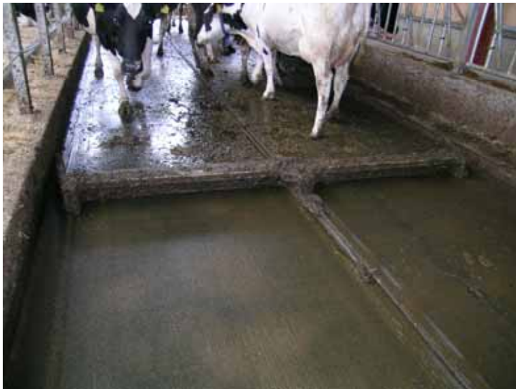
Gummigulv med gødningskraber i gangarealet Foto: Dansk Landbrugsrådgivning
